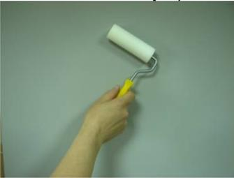
2. Наносим разнонаправленными движениями поролоновым валиком 1-й слой CORREGGIO, разбавленного на 20% водой и колерованного в нужный цвет, максимально гладко и тонко, избегая шагрени.
