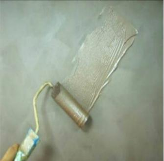
3. Наносим поролоновым валиком 2-й слой CORREGGIO, разбавленного водой на 10%, распределяя материал по поверхности равномерно разнонаправленными движениями
