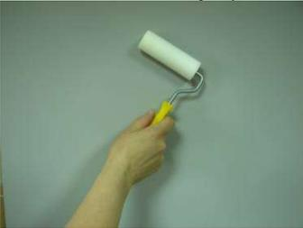
2. Наносим разнонаправленными движениями поролоновым валиком 1-й слой SANETTA, разбавленного на 20% водой и колерованного в нужный цвет, максимально гладко и тонко, избегая шагрени.
