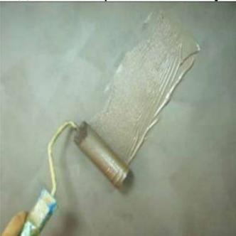
3. Наносим поролоновым валиком 2-й слой SANETTA, разбавленного водой на 10%, распределяя материал по поверхности равномерно разнонаправленными движениями
